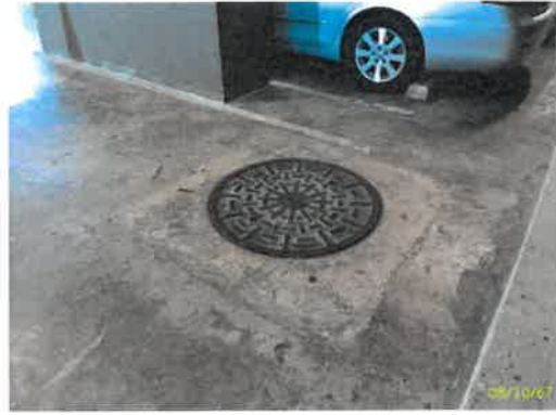
ฝาดังเก็บน้ำสำรองเพื่อการดับเพลิง ชั้นใต้ดิน
