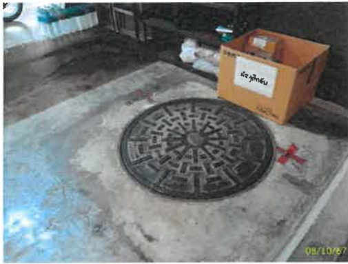
ฝาดังเก็บน้ำสำรองเพื่อการดับเพลิง ชั้นใต้ดิน
